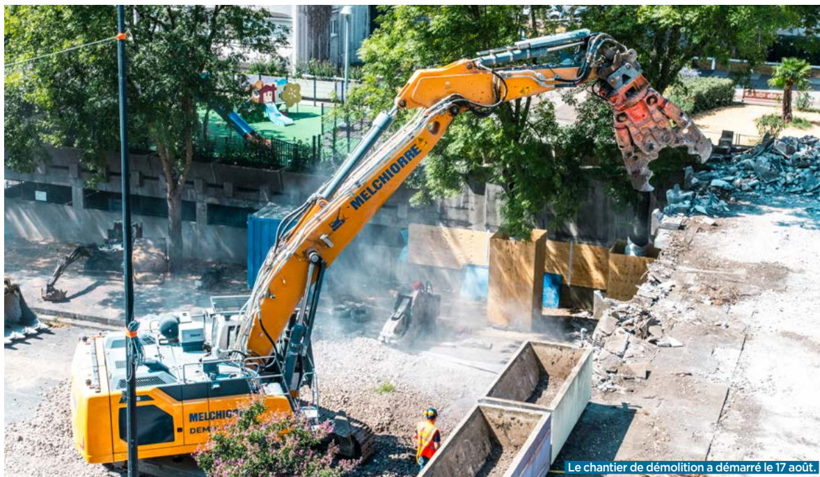
Le chantier de démolition a démarré le 17 août.
