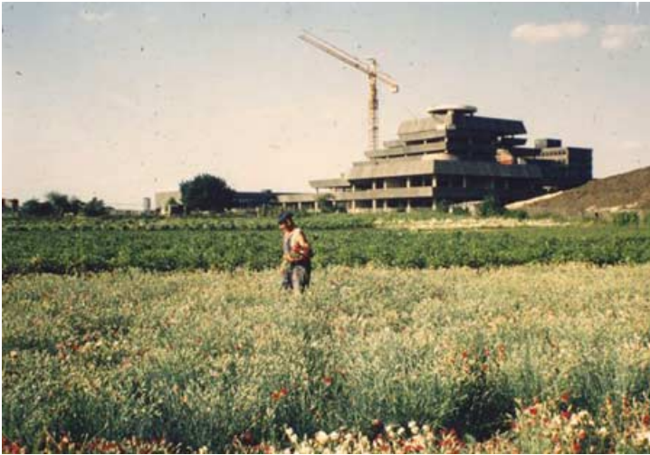
La préfecture de Bobigny en construction
