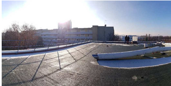
Toiture de l'école Romain Rolland qui devrait accueillir des panneaux photovoltaïques en 2020
