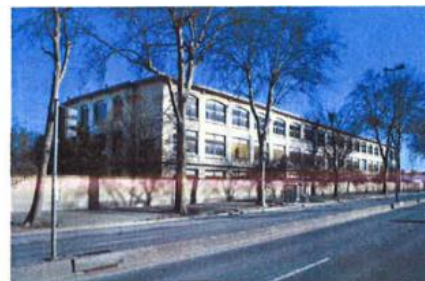
L'ancienne usine Philips
