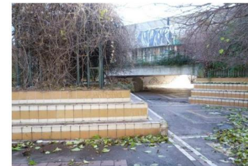
Des accès au parc peu lisibles et peu sécurisants
