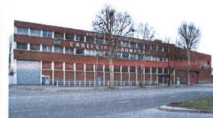
Bâtiment de l'ancien Bronze industriel
