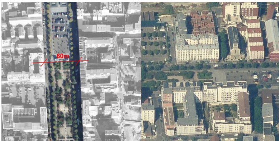
AVENUE DU PRESIDENT WILSON : COUVERTURE DE L'A1 A SAINT-DENIS SOURCE ANTEA GROUP TSC
