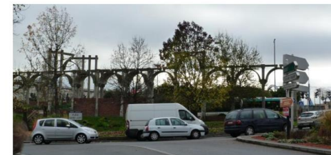
La place Saint-Juste et le pont de Bondy, un carrefour routier qui cloisonne et fait obstacle aux déplacements
