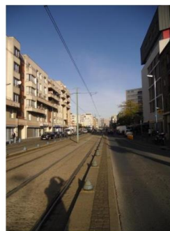
L'avenue Jean Jaurès requalifiée par le tramway au caractère très minéral
