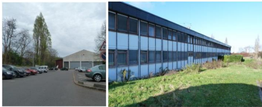
La cité administrative, un site mal identifié comme perdu à l'est du Parc de la bergère, des espaces attenants très peu qualitatifs
