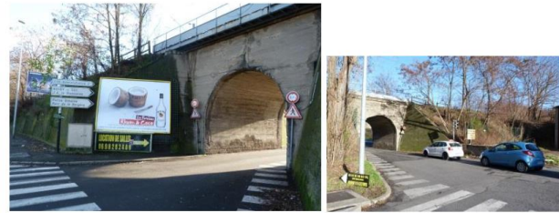
La cité administrative, un accès difficile et confidentiel, la traversée s'effectue par un passage et un carrefour peu sécurisé
